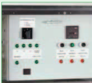
Przełącznik w ochronnej obudowie z licznikiem godzin pracy
